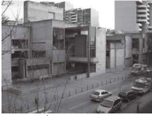
fig 30 École National Supérieure d'Architecture de Grenoble.
