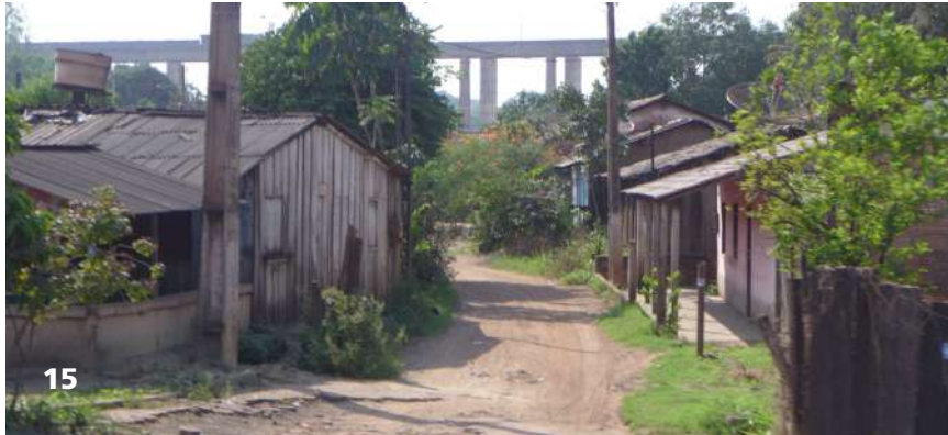
Fig. 15: Piquiá de Baixo and the Carajás Railway in the background, 2018.
